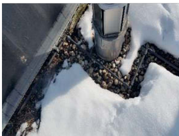
Thermische Solaranlage 25 m 2 Einsparung durch Weglassen Dämmung CHF 1'400.00 Geringere Solarente in 25 Jahren CHF 1'900.00
