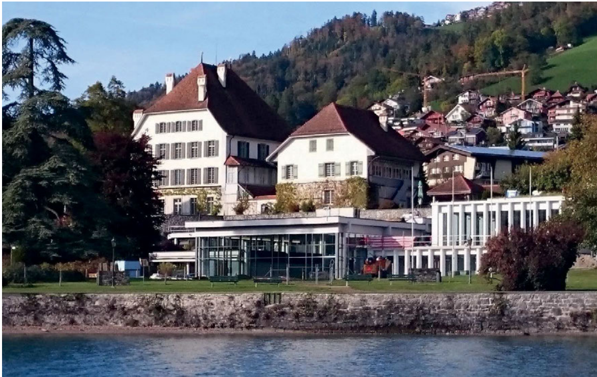
Gesamtansicht mit dem Erweiterungsbau in Bildmitte rechts
