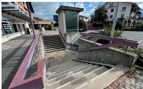
Etappe 2/3: Unterführung gesperrt
