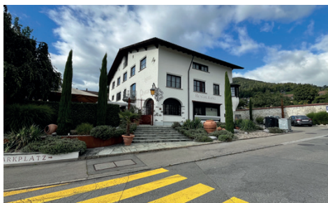
Etappe 4: Gehweg vor Restaurant Chartreuse gesperrt
